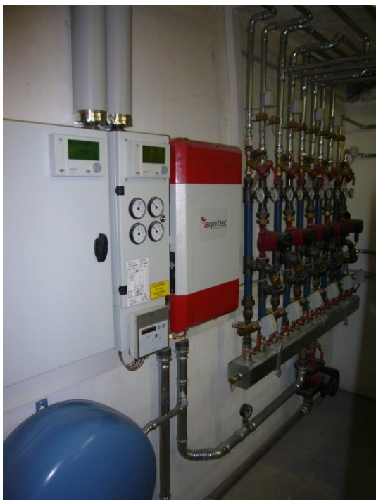
Fernwärmeübergabestation mit Heizkreisregelung und Warmwasserbereitung
