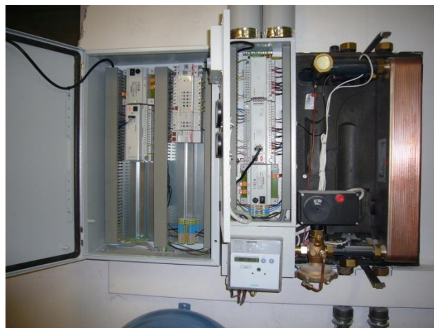
Fernwärmeübergabestation mit Heizkreisregelung und Warmwasserbereitung
